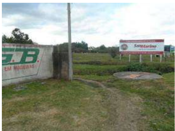
Local da Elevatória Ceval. (Fonte SANEP)
