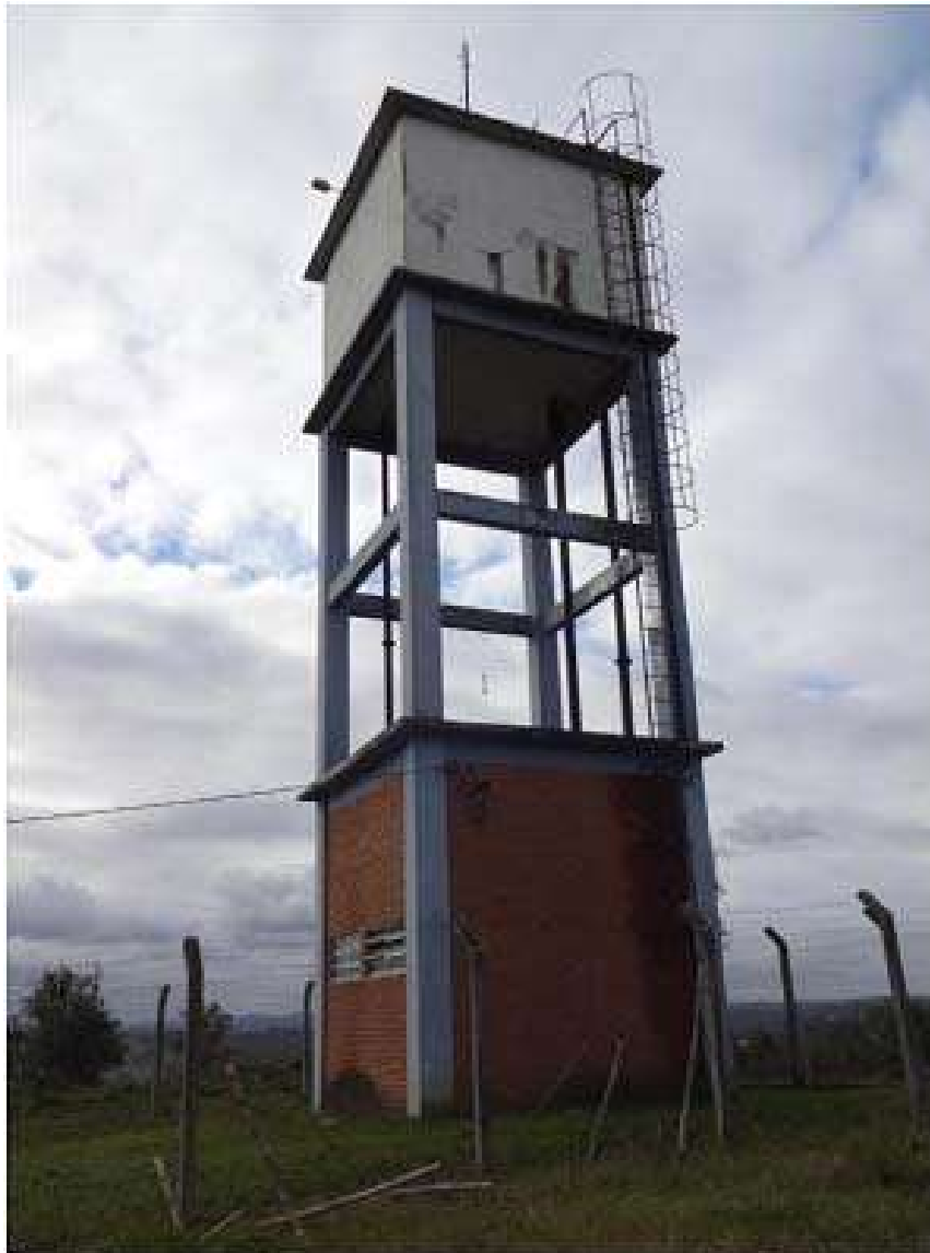
Ilustração 020 – Vista do Reservatório MB-3, localizado na Colônia Monte Bonito.
