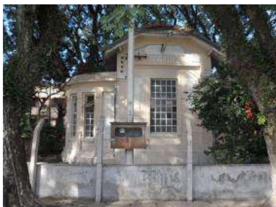
Elevatória Saldanha Marinho US-II. (Fonte SANEP)
