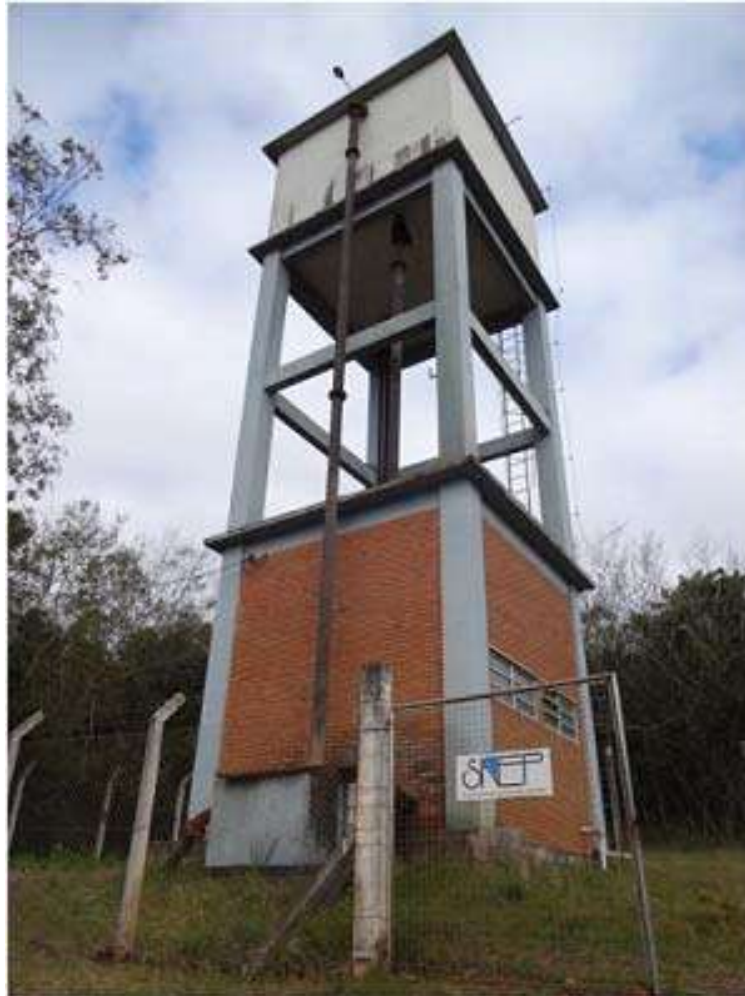
Ilustração 018 – Vista do Reservatório MB-1, localizado na Colônia Monte Bonito.
