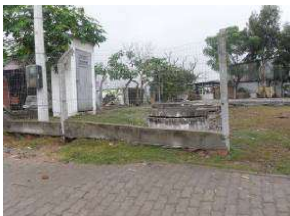
Local da Elevatória Ceval. (Fonte SANEP)
