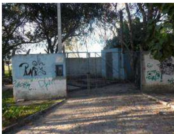
Quadro de comando ELE – Ambrósio Perret. (Fonte SANEP)
