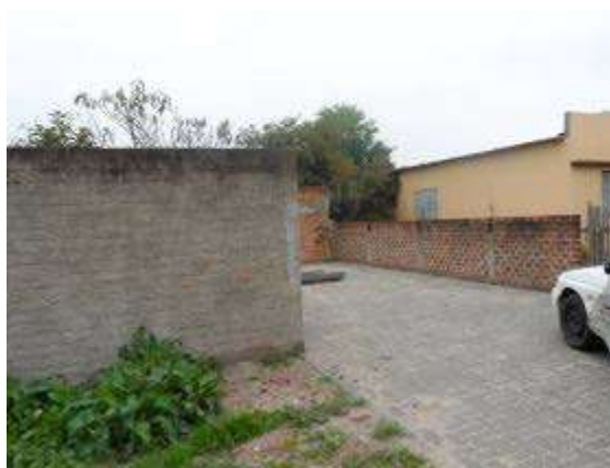
Entrada ELE – Toussaint (desativada). (Fonte SANEP)
