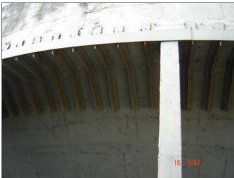
Figura 23 - Reforço estrutural nos reatores necessitando de manutenção (Fonte STE)
