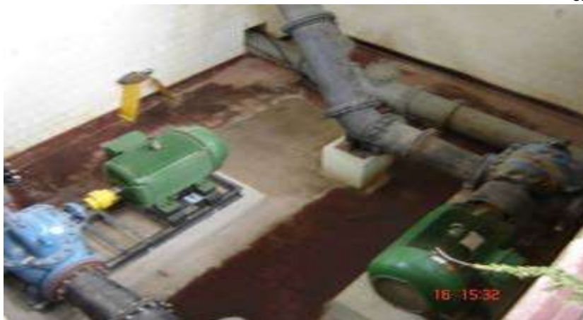
Ilustração 17– Conjuntos motobombas: Para a rede de 500 mm (esquerda); Para a rede 450 mm (direita)
