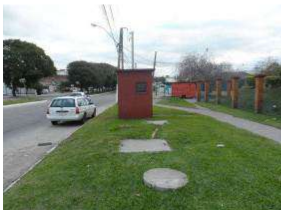
Local da Elevatória Ferreira Viana. (Fonte SANEP)
