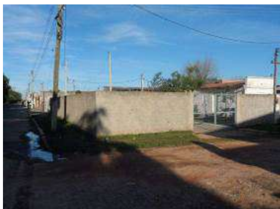
Local da Elevatória Navegantes. (Fonte SANEP)
