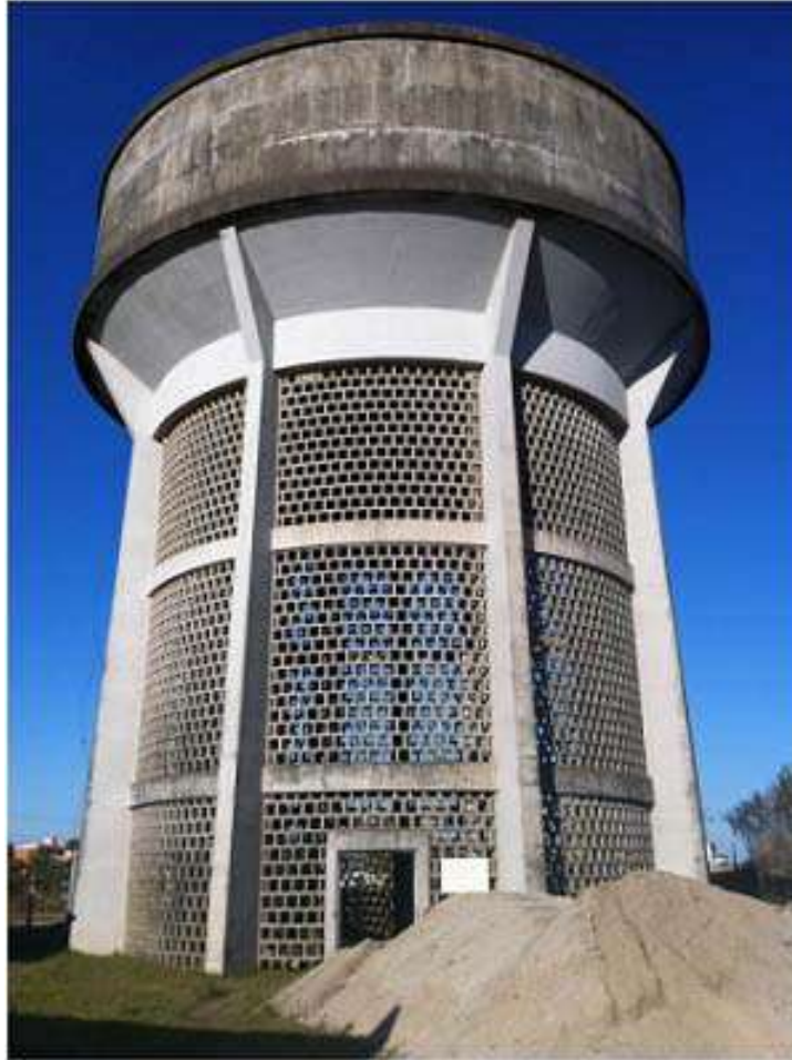
Ilustração 04 – Vista frontal do Reservatório R8.
