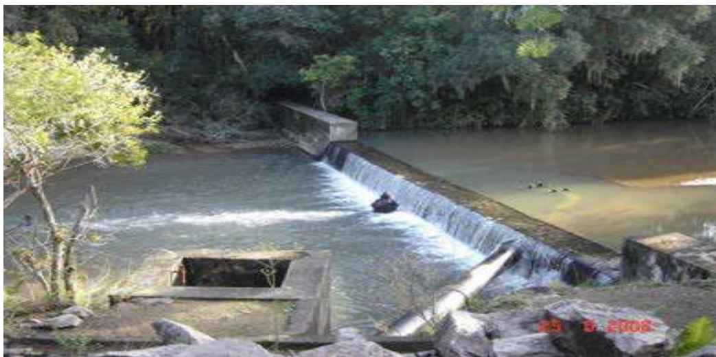
Ilustração 21 - Represinha com vista da captação
