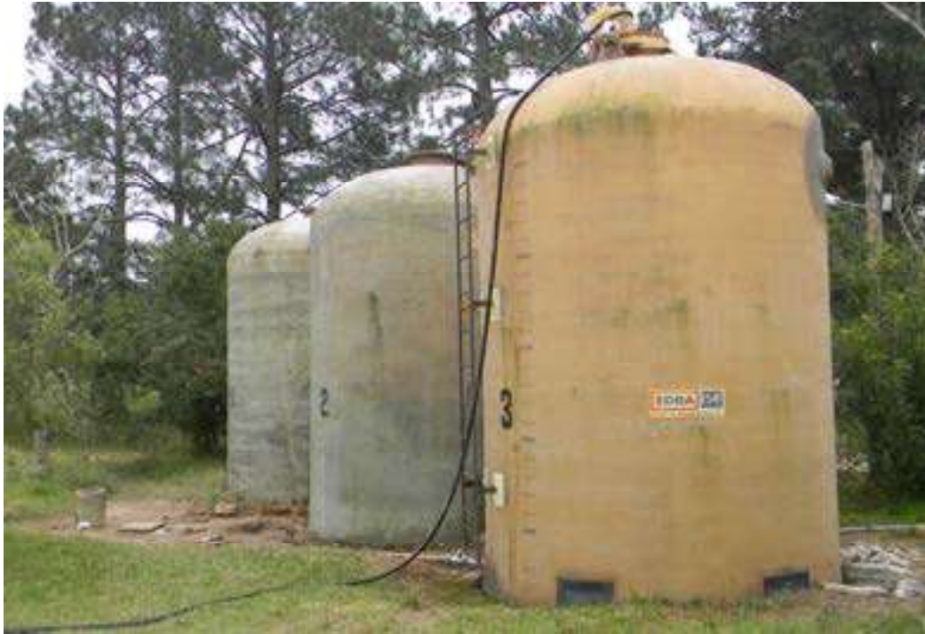
Ilustração 42 – Tanques de PAC
