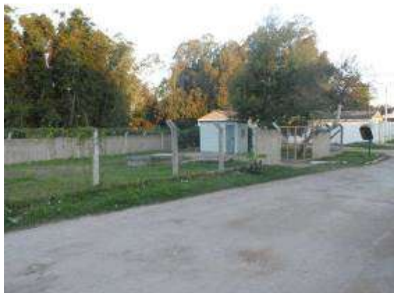
Local da Elevatória Cohab Fragata. (Fonte SANEP)
