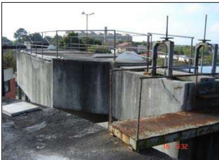
Figura 17 - Desarenador e calha Parshall (Fonte STE)
