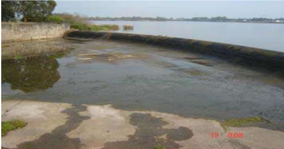
Ilustração 35 – Represa do Santa Bárbara c/ maciço da barragem e vertedor
