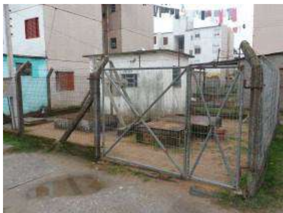
Local da Elevatória Cohab Pestano. (Fonte SANEP)
