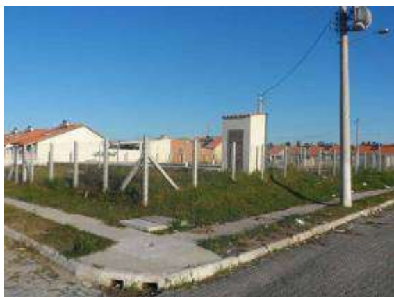
Local da Elevatória Eldorado. (Fonte SANEP)
