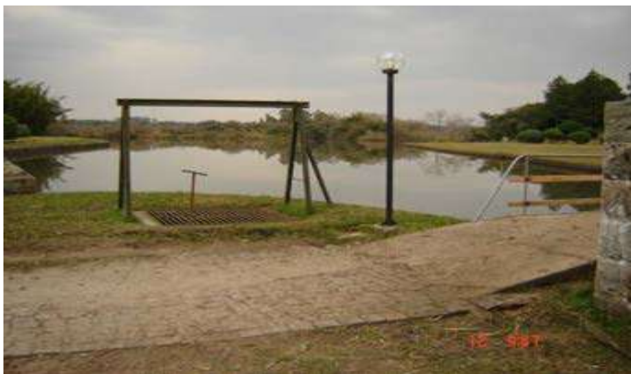
Ilustração 3 - Tomada de água bruta ETA Moreira
