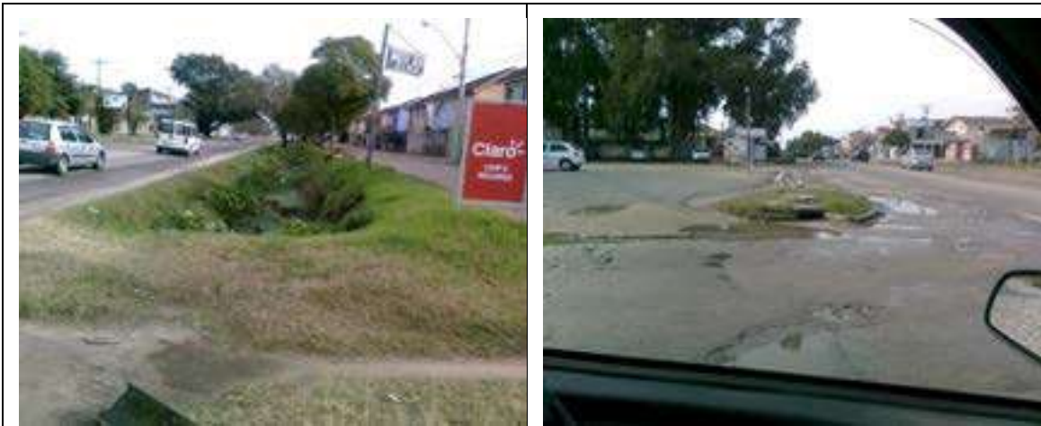
Figura 23: Avenida Salgado Filho, ponto crítico de alagamento.
