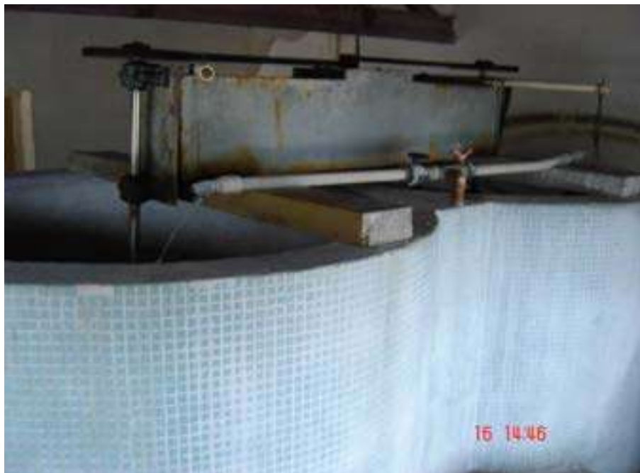
Ilustração 27 - Misturador de flúor
