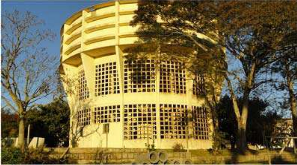
Ilustração 011 – Vista geral do Reservatório R-3.
