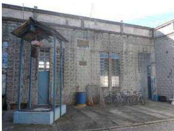
Elevatória US-I. (Fonte SANEP)
