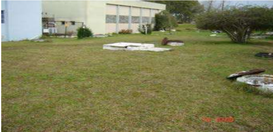
Ilustração 41 - Local onde estão os reservatórios enterrados R6, R61 e R62
