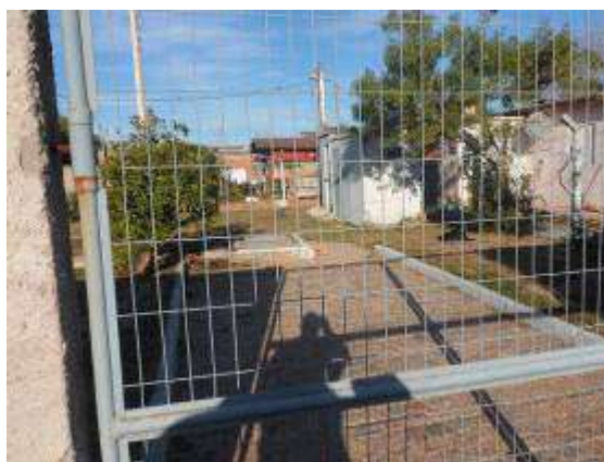
Quadro de comando ELE – Navegantes. (Fonte SANEP)
