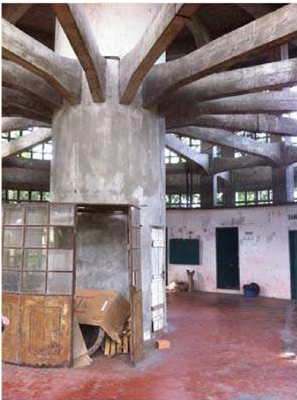
Ilustração 03 – Interior do Reservatório R4.
