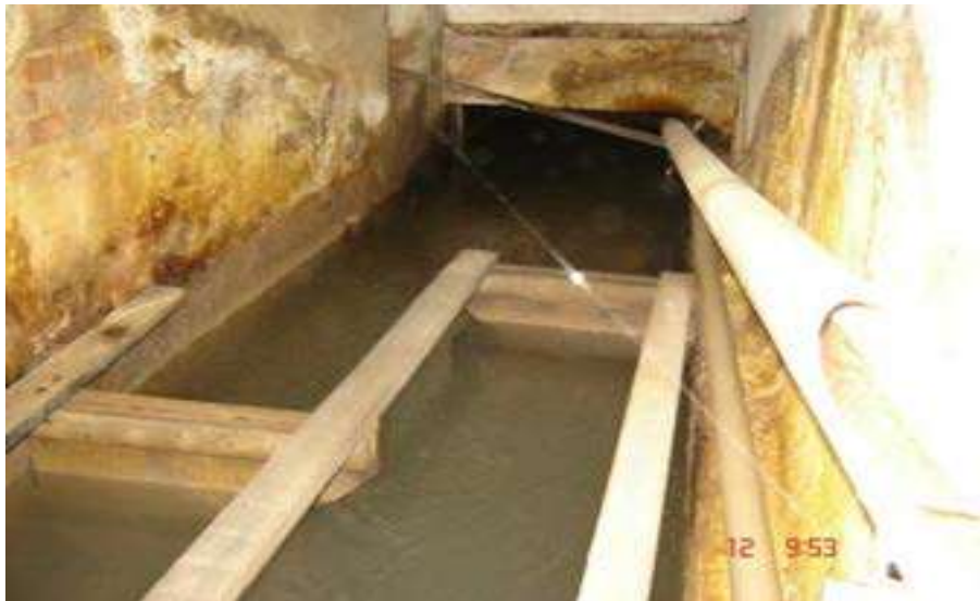
Ilustração 6 – Calha de mistura com chicanas
