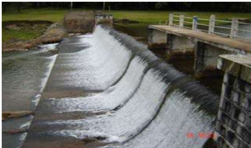
Ilustração 19 - Represa do Quilombo vendo-se no primeiro plano, peça de acionamento das comportas e no fundo a estrutura de contenção empuxos de terra.
