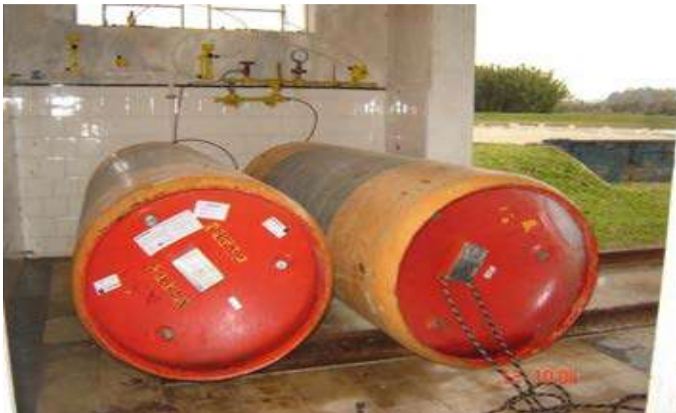
Ilustração 09 - Cilindros de Cloro
