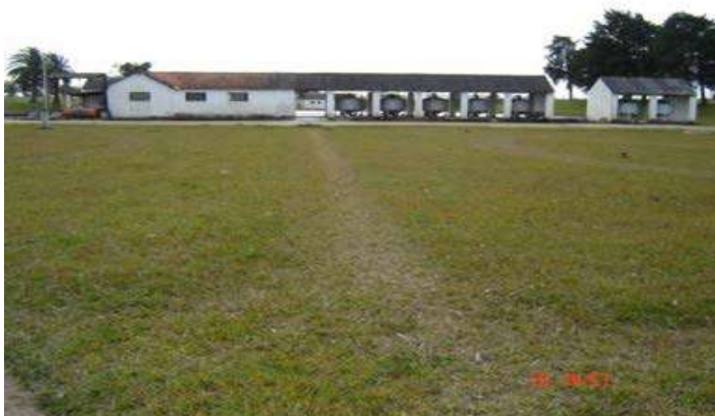
Ilustração 28 - Local do reservatório enterrado com 8.000m 3
