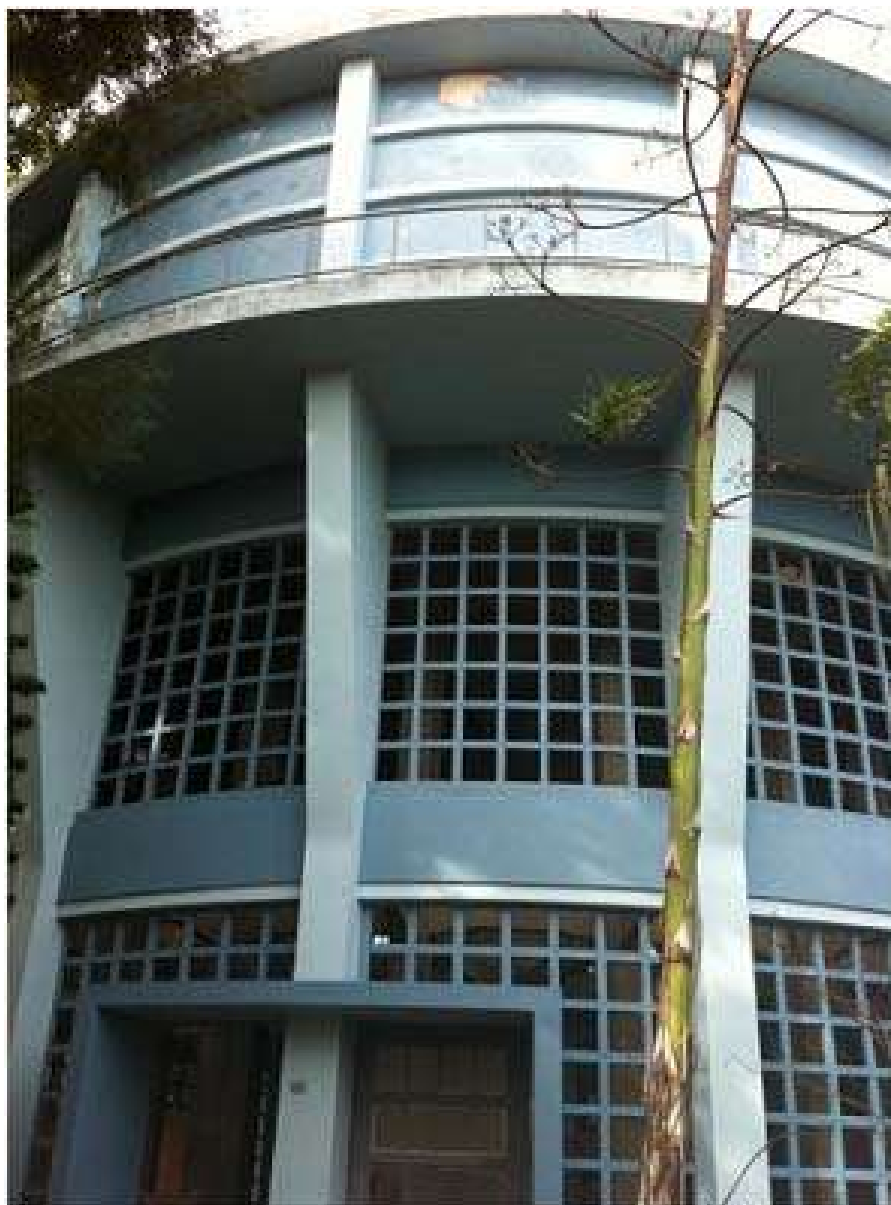
Ilustração 02 – Vista frontal do Reservatório R4.
