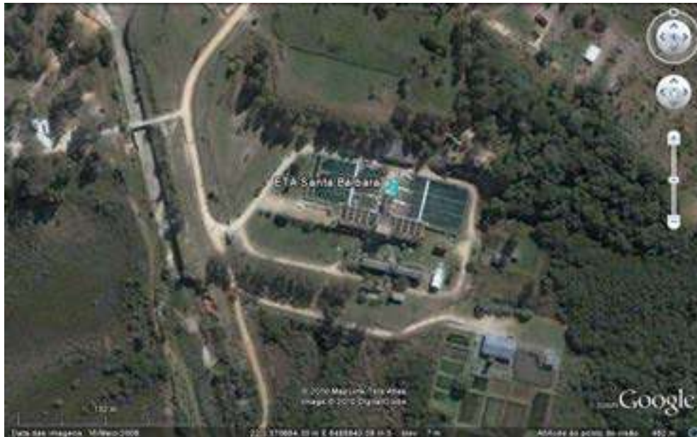
Ilustração 34 – Vista da ETA Santa Barbara
