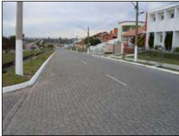
Figura 3.31 – Meio-fio após serviço de pintura
