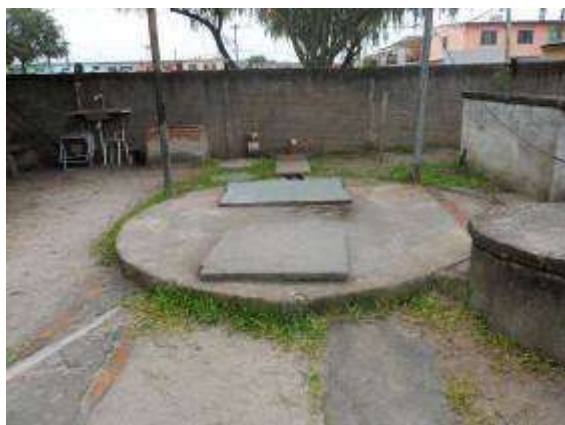
Local da Elevatória Guabiroba . (Fonte SANEP)
