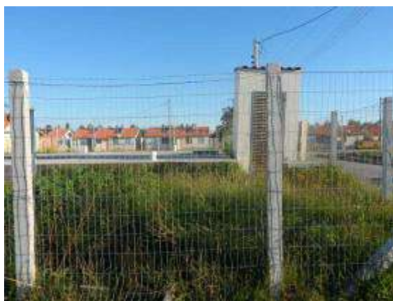
Quadro de comando ELE – Eldorado. (Fonte SANEP)
