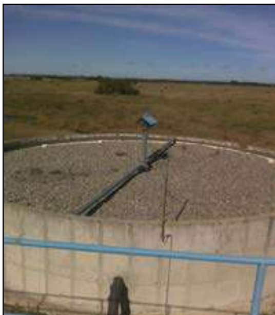
Figura 32 - Vista superior do filtro biológico (Fonte STE)
