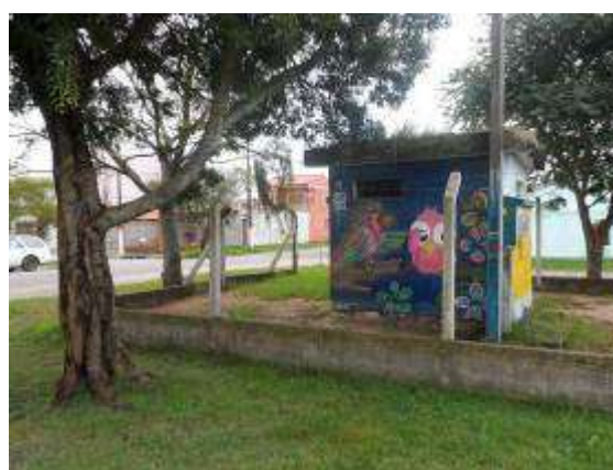
Quadro de comando ELE – Umuharama. (Fonte SANEP)
