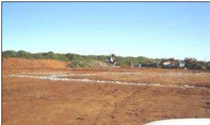
Foto 3.5 – Lançamento do sistema de drenagem de chorume
