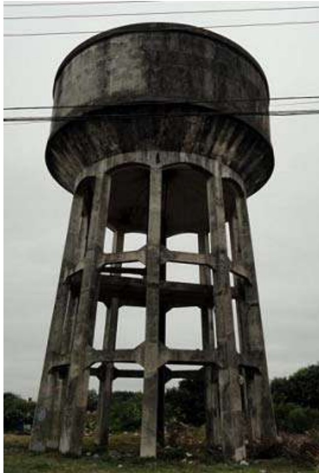
Ilustração 05 – Vista frontal do Reservatório R7.
