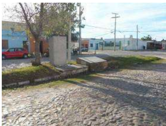
Local da Elevatória Fátima. (Fonte SANEP)
