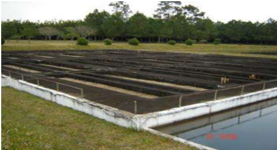
Ilustração 08 - Antigos filtros horizontais
