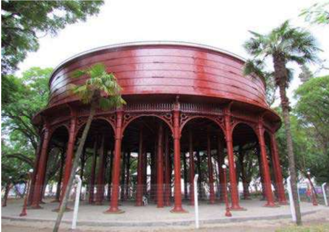
Ilustração 05 – Vista frontal do Reservatório R1.
