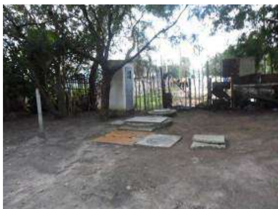
Local da Elevatória Vila Castilho. (Fonte SANEP)
