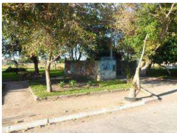
Local da Elevatória Ambrósio Perret. (Fonte SANEP)
