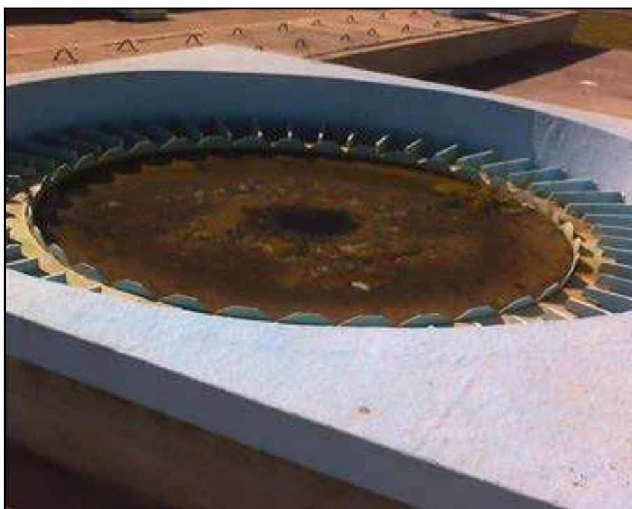
Figura 28 – Reator anaeróbio (Fonte STE)
