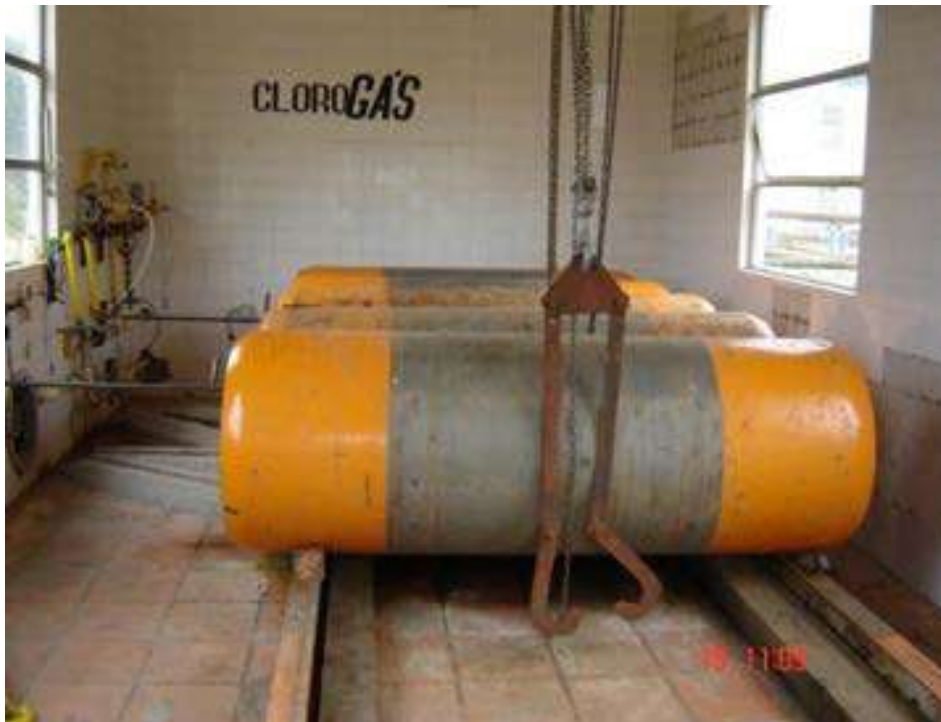
Ilustração 45 - Cilindros de cloro
