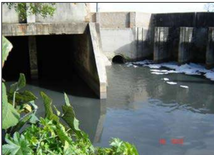
Figura 25 - Ponto de lançamento do efluente (Fonte STE)
