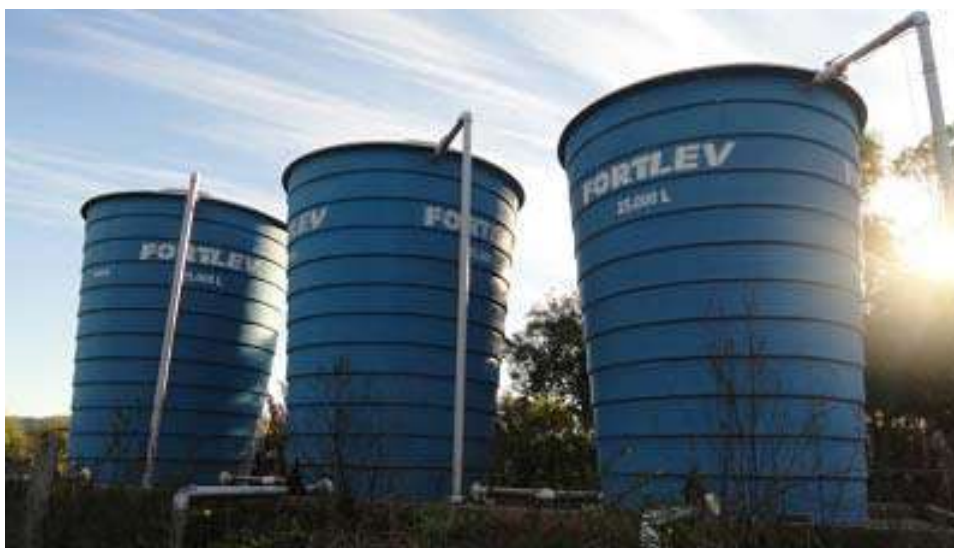
Ilustração 026 – Vista dos reservatórios, localizados na Colônia Quilombo.
