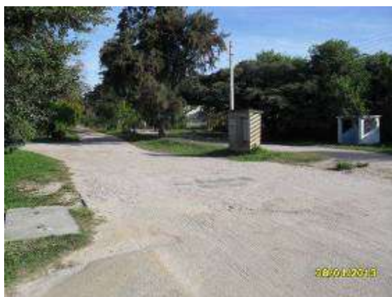
Local da Elevatória L1. (Fonte SANEP)
