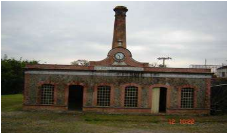
Ilustração 2 - Casa de Bombas e Museu do Moreira
