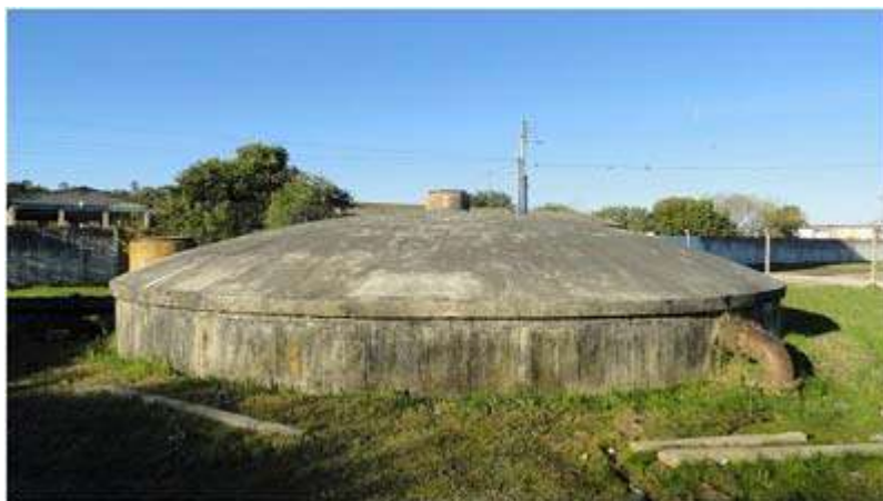
Ilustração 09 – Vista frontal do Reservatório inferior, semi-enterrado.
