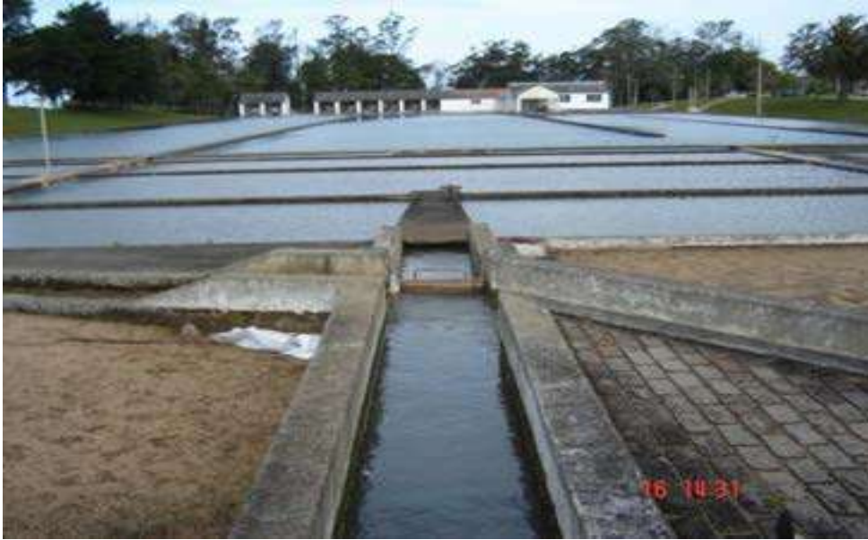
Ilustração 24 - Pré-filtros e decantadores
