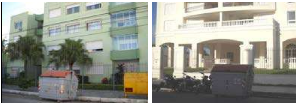
Figura 3.11 e Figura 3.12 – Situação após a implantação
