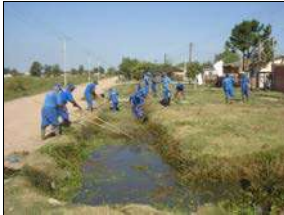
Figura 3.33 – Limpeza de valetas
